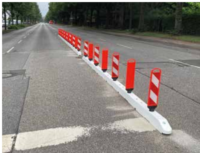
Leitborde mit Warnbaken kurz nach der Fertigstellung auf dem Schiffbeker Weg Höhe Sturmvogelweg
