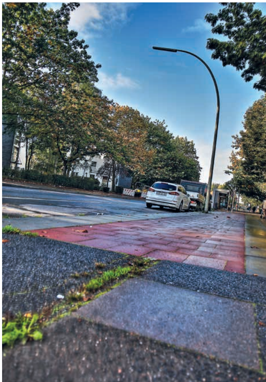
Radweg Möllner Landstraße: Der neu gebaute Radweg ist deutlich breiter als der alte. Foto: Frank Berno Timm
